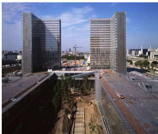
BnF, jardin et esplanade en chantier, septembre 1994 © Michel Denancé
