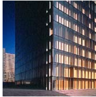
Bibliothèque Nationale de France, 1989-1995, concours international, Paris, France
