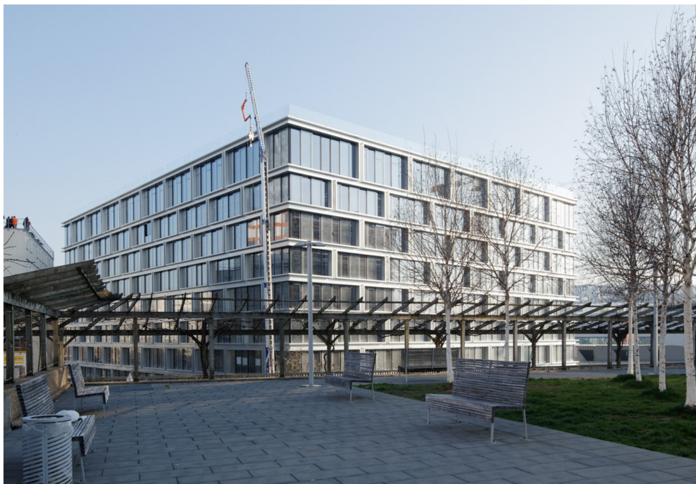
Façades Nord et Ouest, 2022
